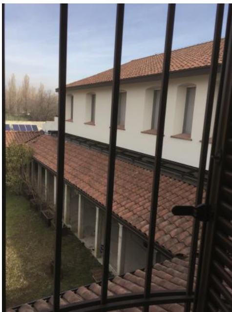
Chiostrino interno delle monache con il nuovo tetto.
